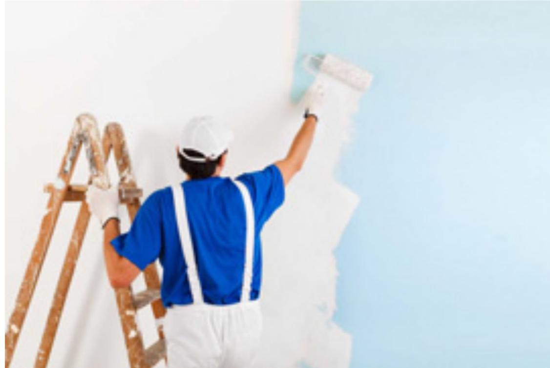
Pareti e soffitti saranno rifinite con pitturazione in tinta unica bianca con mano di fondo in isolante ed idropittura acrilica.
